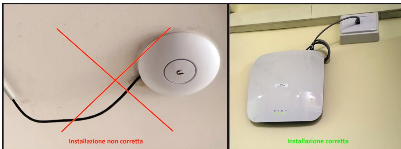
Figura 10 – Installazione corretta dell'Access Point
